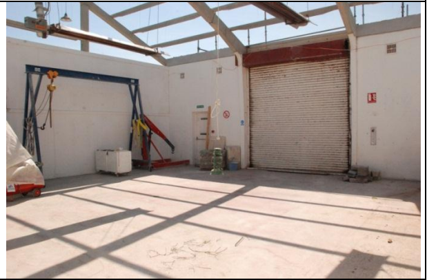
ガレージ内(リノベーション中) 写真奥にあるクレーン(2機)が石を吊るすクレーン
