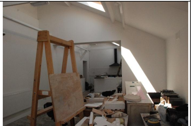
カフェギャラリー (リノベーション中) 写真奥がキッチン
